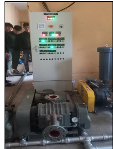
Thay thế máy thổi khí, tủ điều khiển
