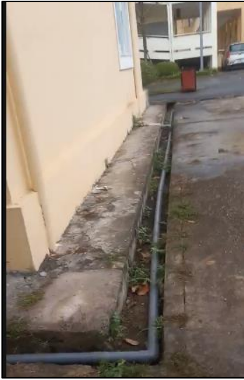
Thay đường ống thu gom nước thải bị tắc
