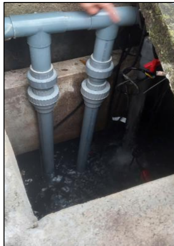
Thay thế bơm nước thải bể điều hòa
